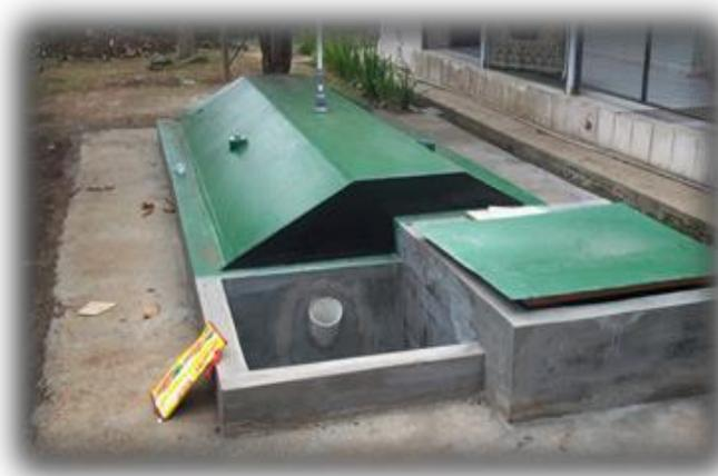
**Gambar 24.** Biodigester Sampah Skala Rumah Tangga
